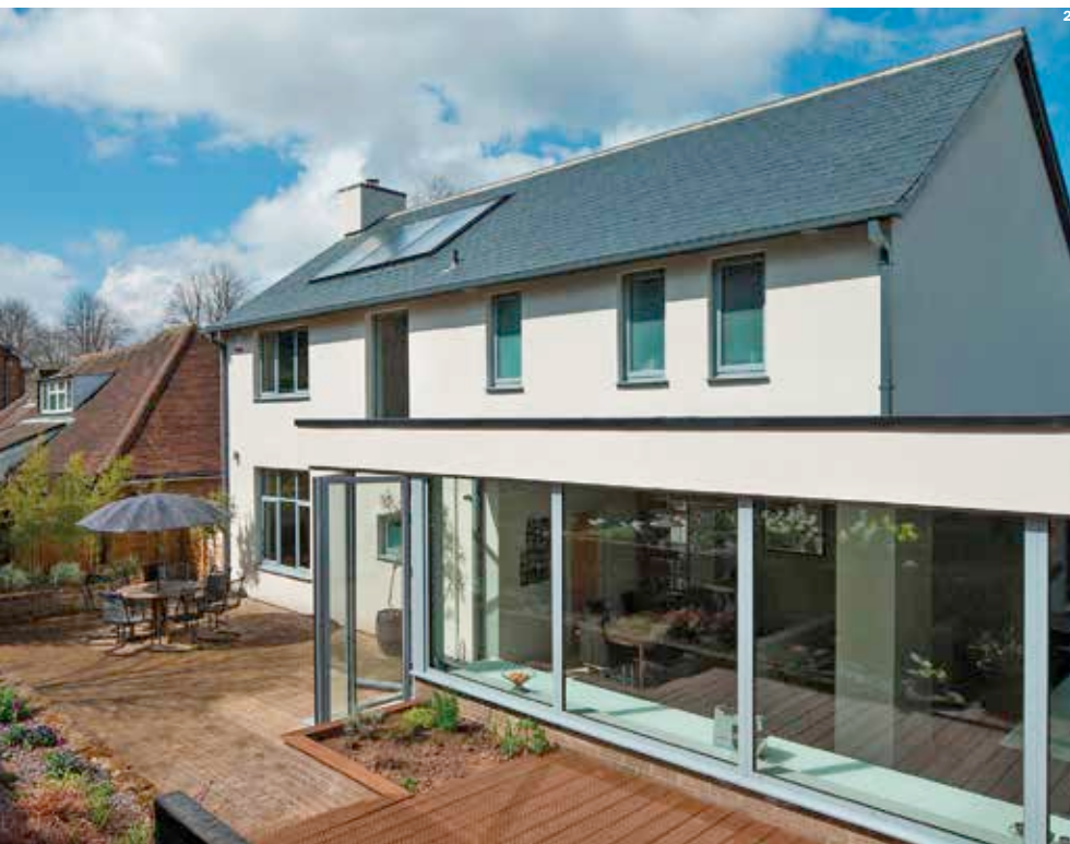
▲ VÝSTAVBA nového domu je často levnější než kompletní rekonstrukce. Tu mohou výrazně prodražit třeba demoliční práce.
